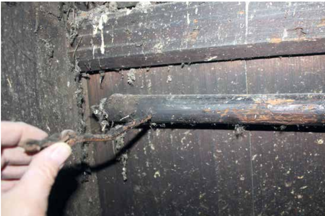
Abb. 12: Die linke Seite des Schlagumlenkhebels, von hier führte der Drahtzug zum Schlaghammer an einer Glocke
