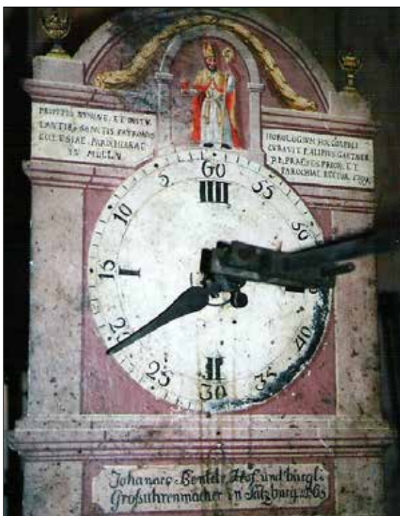
Abb. 11: Das Kon- trollzifferblatt Mülln aus 1799 hat nur den Minutenzeiger.
